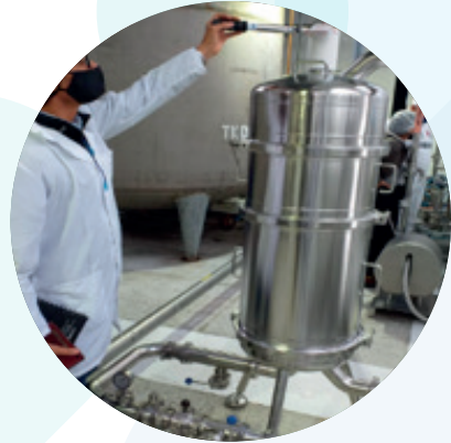
Supervisión montaje equipo de filtración para línea de producción
